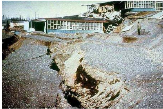
1964 年地震时由于地面塌陷而被分开的小学
