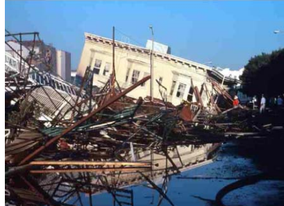
1989 年 10 月 17 日地震旧金山倒塌的房屋
