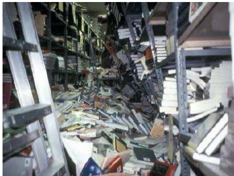
1994 年北桥地震时加州大学北桥分校倒塌的书架
