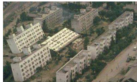
地震中倒塌的楼房
